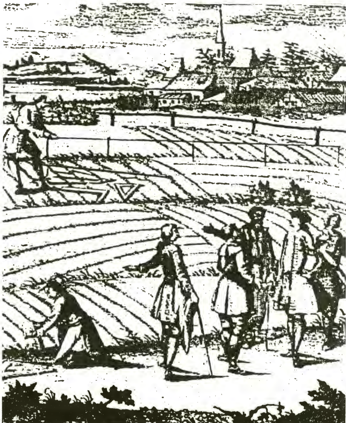
Feldrichter, Untergänger oder „Siebener“ beim Vermessen und Marktsteinsetzen (um 1754)
