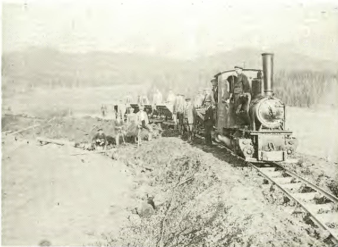
Bahnbau vor 75 Jahren. Ein Lorenbauzug beim Aufschütten des Bahndammes vor Schömberg.
