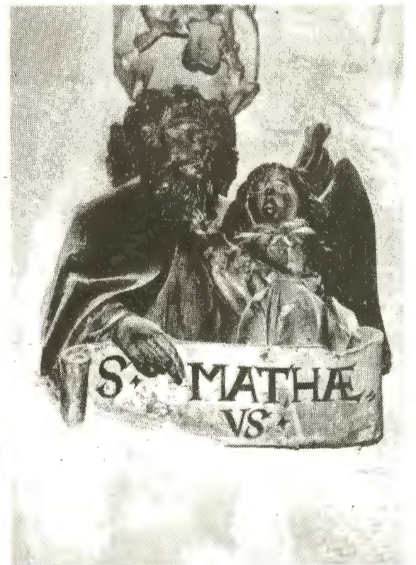
Schon 1457 wurde mit der ikonographischen Ausschmückung des Langhauses begonnen, die Evangelisten Matthäus und Johannes wurden an der Ostwand des Langhauses angebracht. Die übrigen Brustbilder (je zwölf Apostel und alttestamentliche Könige und noch zwei Evangelisten) stammen von Meister Franz.
