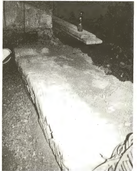
Ein Stück der freigelegten Fundamentmauern der Nikolaus- und Liebfrauenkapelle.
