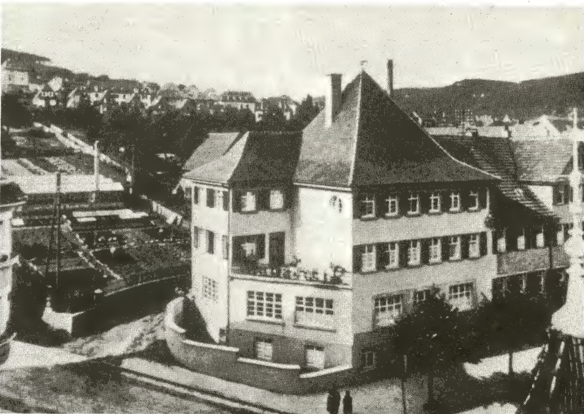
Die „Augustenhilfe“ vor dem Abbruch
