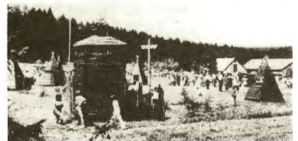
Ebingen – Freizeitanlage Rosßberg, ca. 1980
