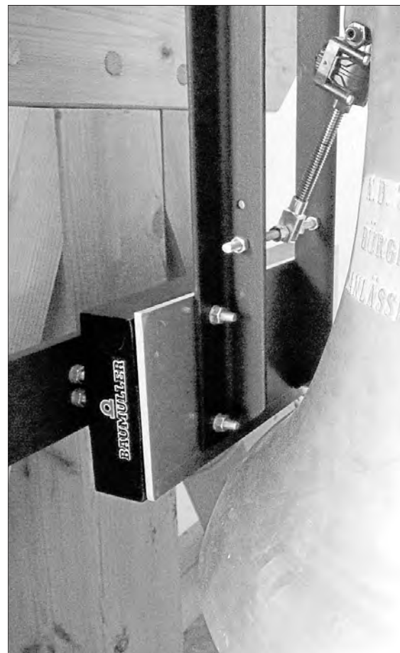
Berührungsloser Glockenantrieb mit Pulsgeber und Magnet
