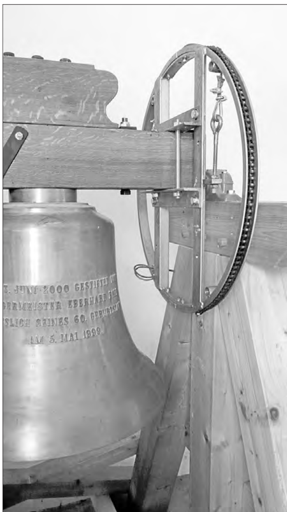
Klassischer Glockenantrieb mit Antriebsrad
