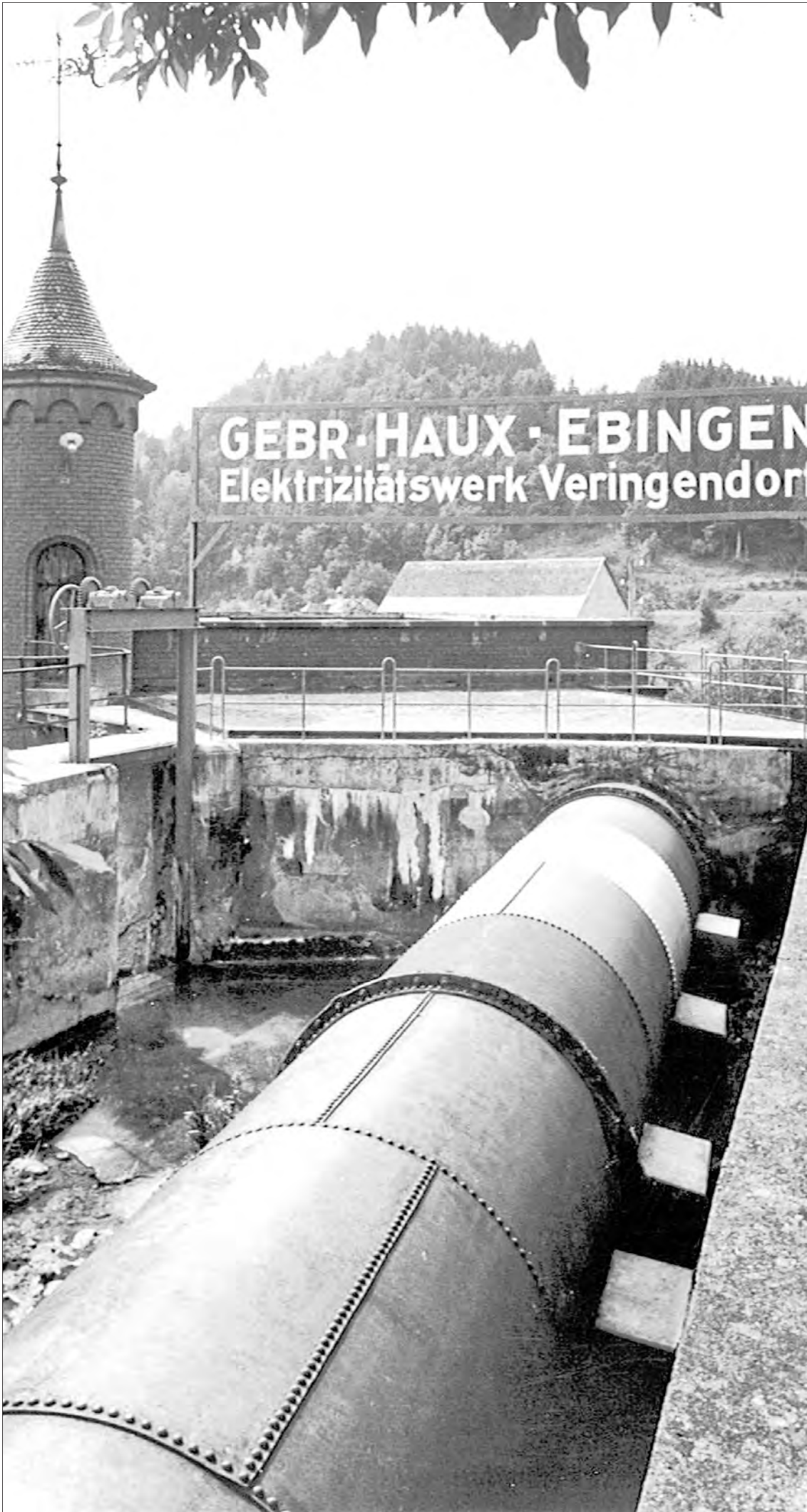
Das Elektrizitätswerk Haux in Veringendorf.
