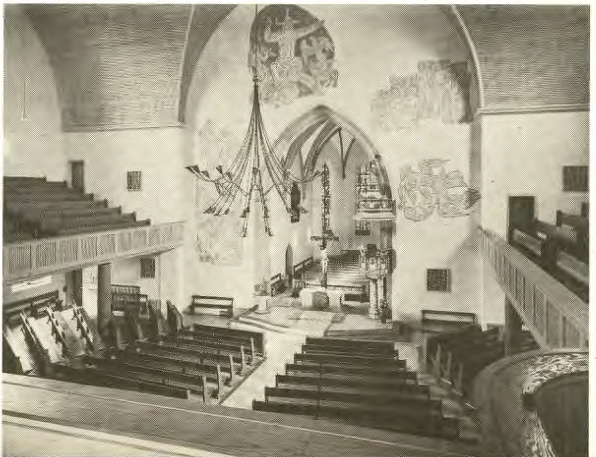
Die Ebinger Martinskirche nach dem Umbau von 1954
