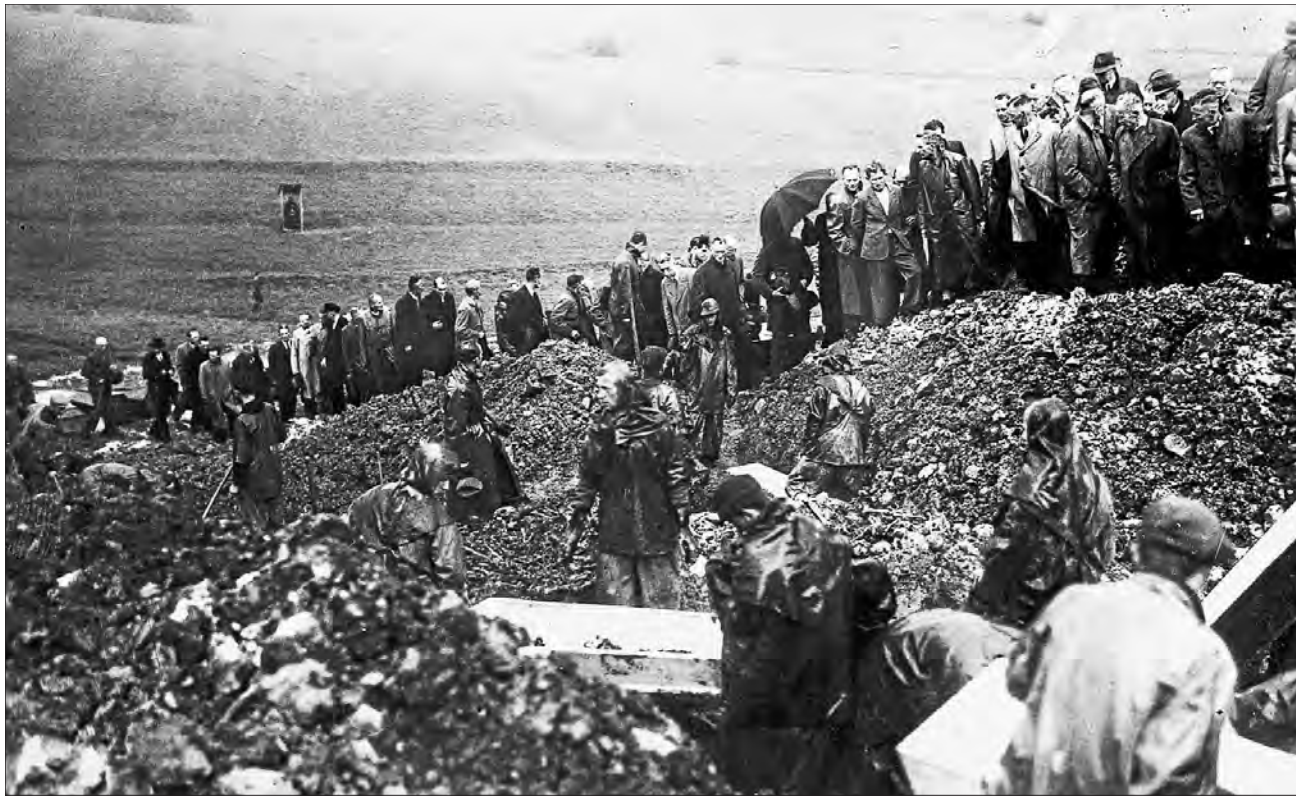
Exhumierung Massengrab Schömberg Schönhager Loch: Exhumierungsarbeiten, Besuch deutscher Honoratioren
